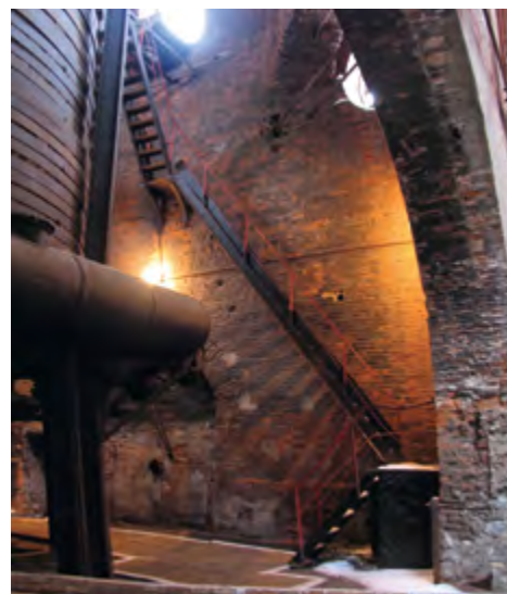
^ Рис. 7. Внутренняя лестница на колошниковую площадку домны. 2006
