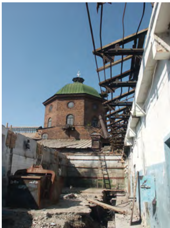
> Рис. 4. Начало реконструкции кровли. 2006
