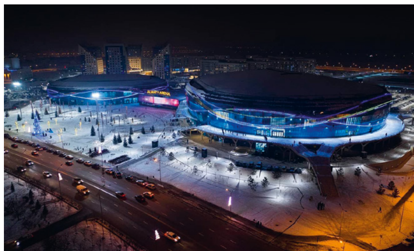
^ Рис. 4. Ночной вид здания «Алматы Арена» ( https://ticketon.kz/en/place/almaty-arena-ft )
