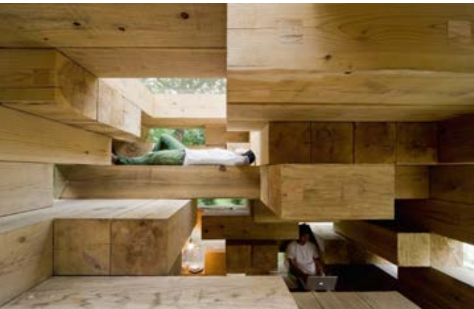
v Со Фуджимото, Jenda House. Последний деревянный дом, Кумамура, Япония, 2005-2008 / Sou Fujimoto, Jenda House. The last wooden house, Kumamura, Japan, 2005-2008
