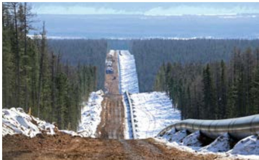
^ Строительство магистрали «Сила Сибири»
