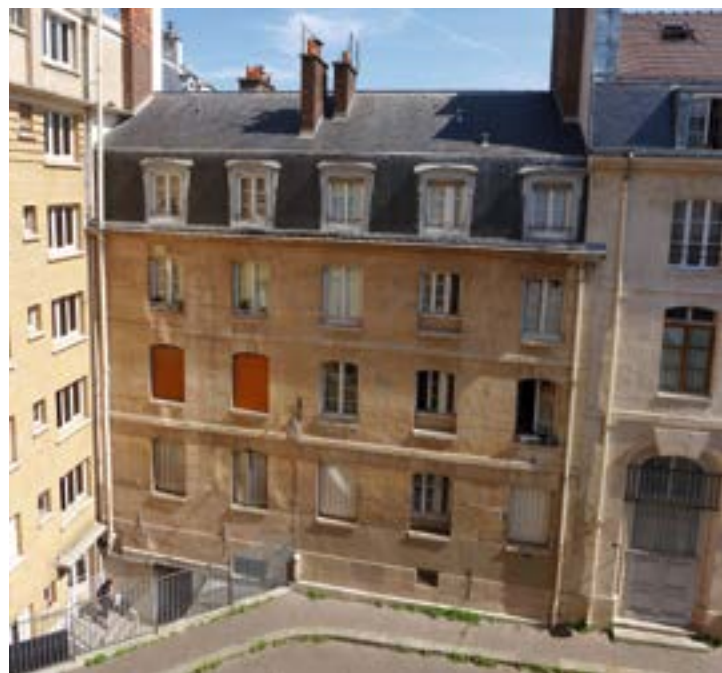
v Каменный фасад здания XVII века. Автор: Office Atelier de la Seine / Rethink 2017 / The stone façade of the 17th century building. Author: Office Atelier de la Seine / Rethink 2017
