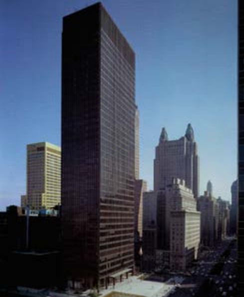
^ Мис Ван дер Роэ. Сиграм-билдинг. Один из первых стеклянных небоскребов, открывший эру нового небоскребо-строения
