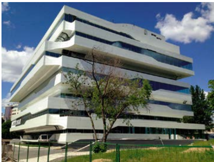
^ Бизнес-центр «Доминион-Таур», Москва, арх. Заха Ходид. 2016
