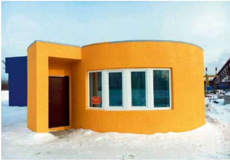
^ Первый дом в России, напечатанный на 3D-принтере. Автор: Apis Cor / The first 3D-printed house in Russia. Author: Apis Cor
