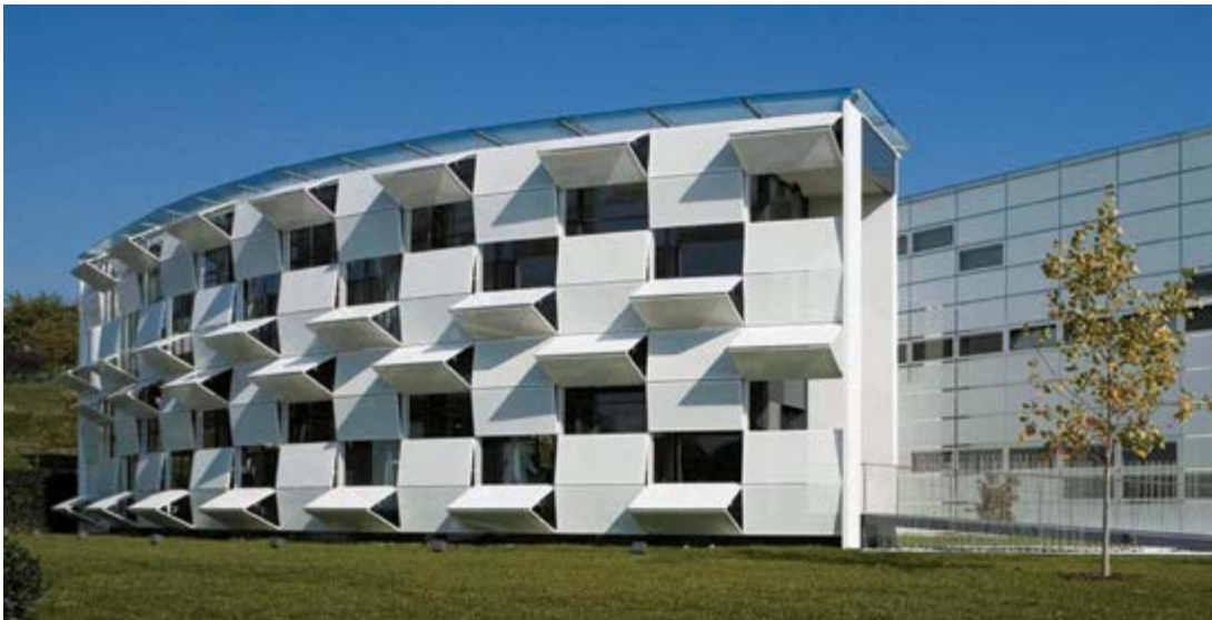
v Трансформируемый фасад. Архитектор Эрнст Гизельбрехт
