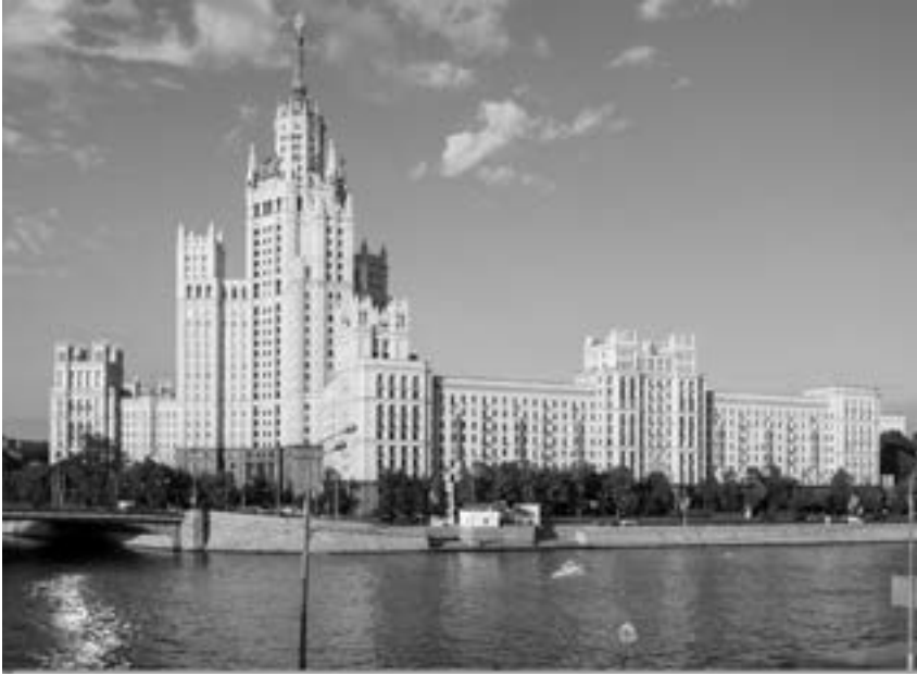
< Жилой дом на Котельнической набережной. Арх. Д. Чечулин, А. Ростовский, инженер Л. Гохман
