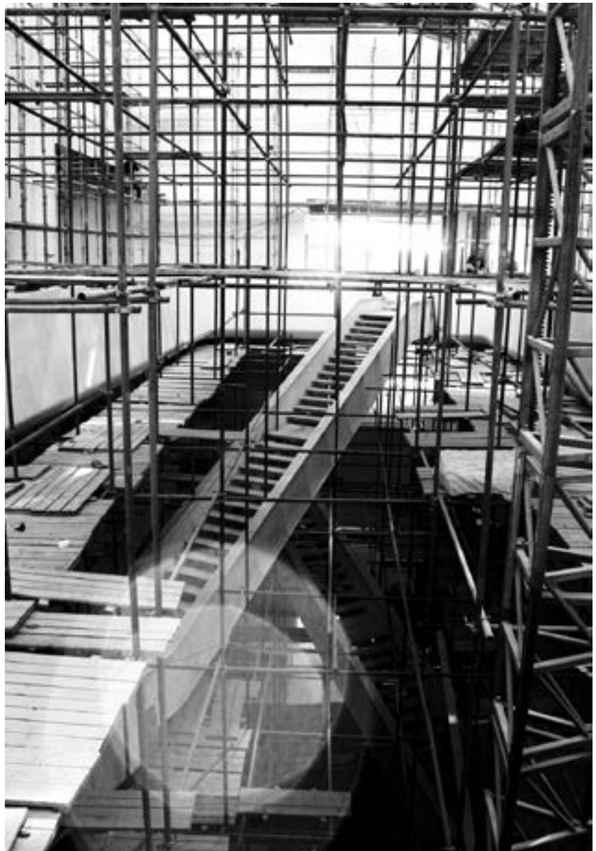
v Рис. 6. Монтаж лестницы в интерьере Dominion Tower
