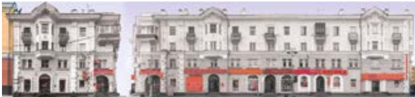
Улица Ленина, 24 (слева – с улицы Горького, справа – с улицы Ленина). Выделение на фасаде объектов рекламно-информационного назначения
