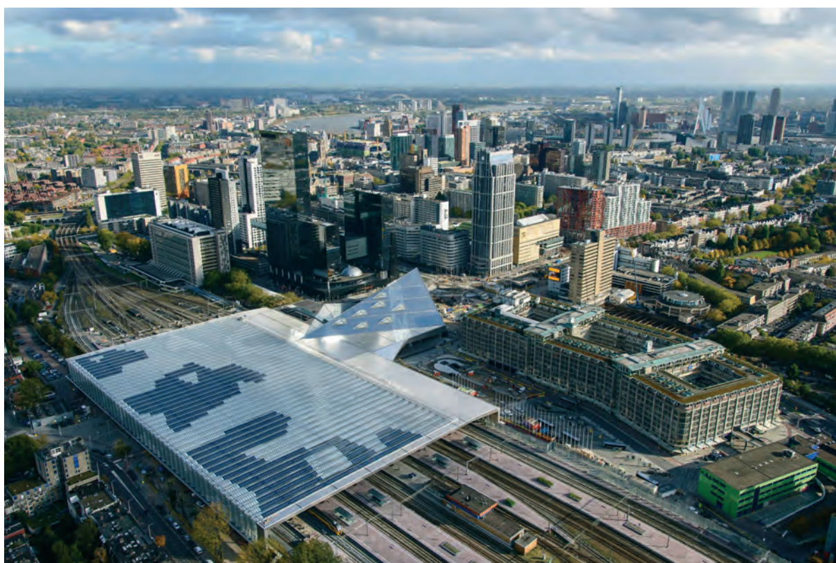
< Крыша с солнечными батареями / The solar roof
