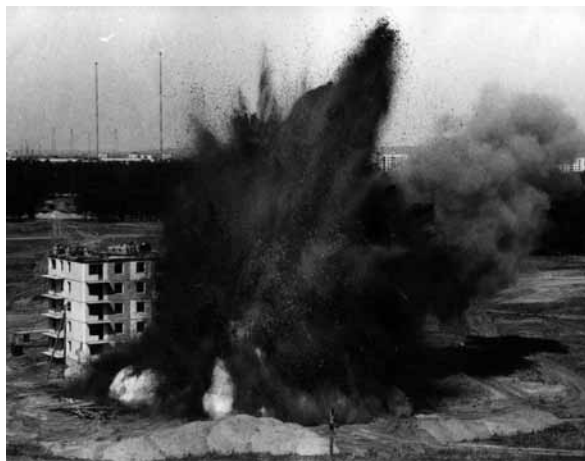
Сейсмозрывные испытания жилого дома в г. Ангарске
