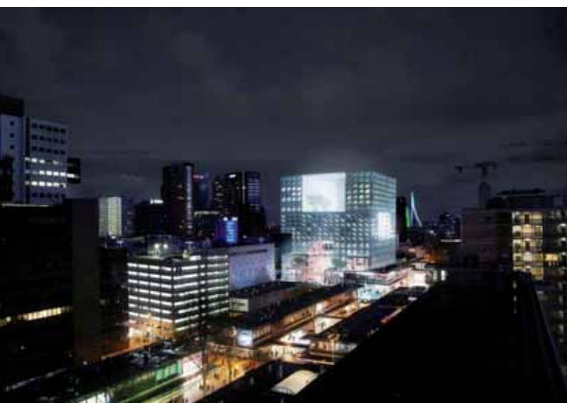
v Рис. 14. Роттердамский форум по проекту OMA и Cool63 по проекту Allies & Morrison / Rotterdam Forum by OMA and Cool63 by Allies & Morrison
