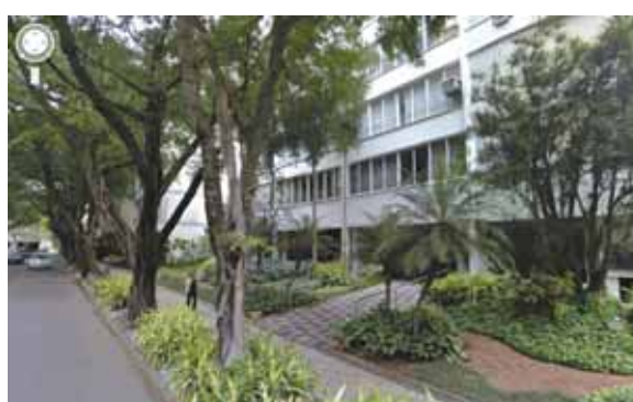
< Original situations without perimeter fencing in the neighbourhood Ipanema. Photo: Google Maps / Нетипичный пример отсутствия ограждения в Ипанеме. Фото: Google Maps
