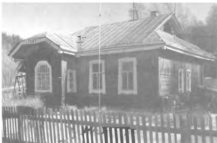
Путевая постройка – полуказарма 2-го пути. 106 км
