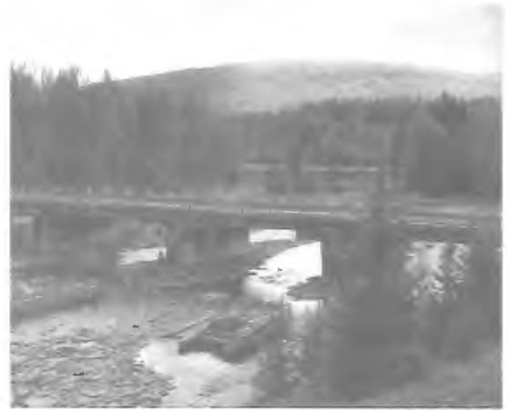
Опоры-ряжи старого моста через Куленгу. 2002 г.
