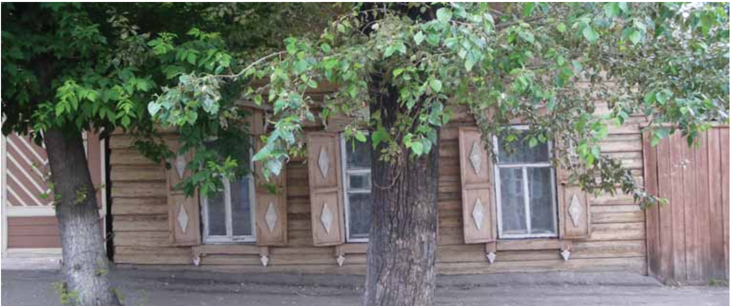
^ Рис. 1. Главный фасад дома по ул. Марата, 41
