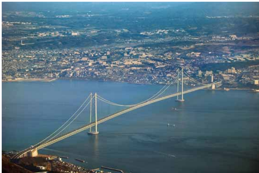
Рис 1. Акаши-Кайкио, Япония: подвесной мост с самым большим пролетом между опорами. Мост способен устоять при землетрясении силой 8,5 балла, он выдерживает порывы ветра до 286 км/ч. Общая длина сооружения – 3 911 м, высота – 65 м. Автомобильное движение организовано по шести полосам
