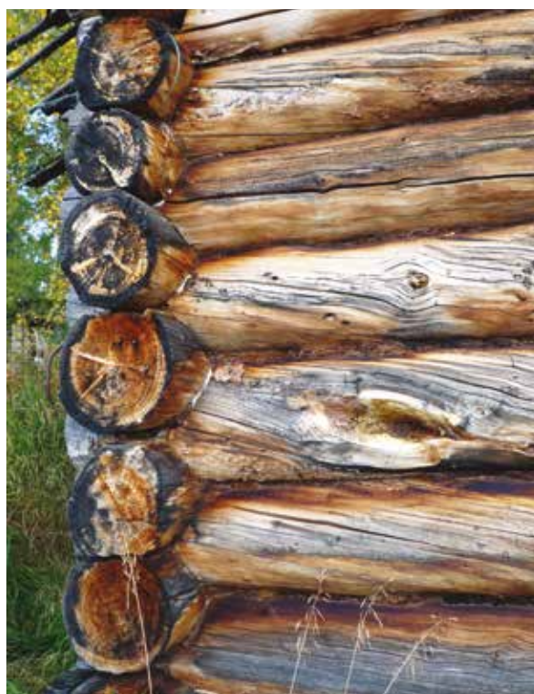
Рис. 17, 18. Примеры «неиндустриальных» срубов современных зимовий, сложенных из бревен, заготовленных в окрестностях Ханды
