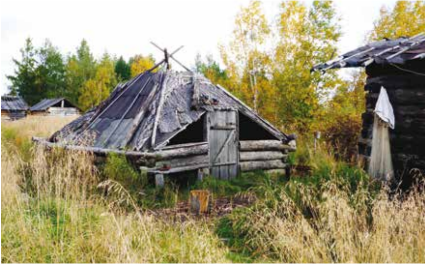
Рис. 7, 8. Наиболее характерное в комплексе Агджени зимовье-чум – крыто корой. Дымоход над очагом, как и у других, «оформлен» эффектным выпуском жердей, конструктива «стропильной системы»
