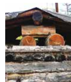
Рис. 19-а, б, в, г. Варианты конструктивных чердачных узлов, обеспечивающих поддержание в устойчивом (или не очень устойчивом) состоянии крыши современных таежных жилищ промысловиков в Казачинско-Ленском районе Иркутской области (а – Алларук, б, в – Агджени, г – Дивиткан)
