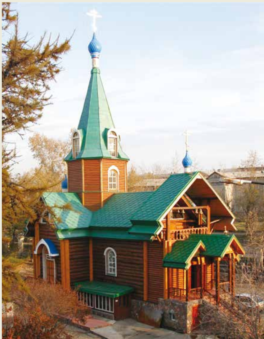
Храм Святой Ксении Петербургской в Иркутске. Авторы: арх. В. Стегайло, О. Бадула. Проект 1997-1999 гг., строительство 1999-2003 гг.
