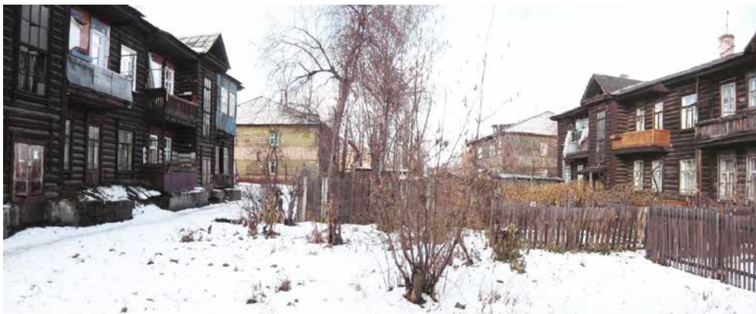
Рис. 1. Иркутск, пер. Восточный. Сохранившийся квартал деревянных двухэтажных жилых домов
