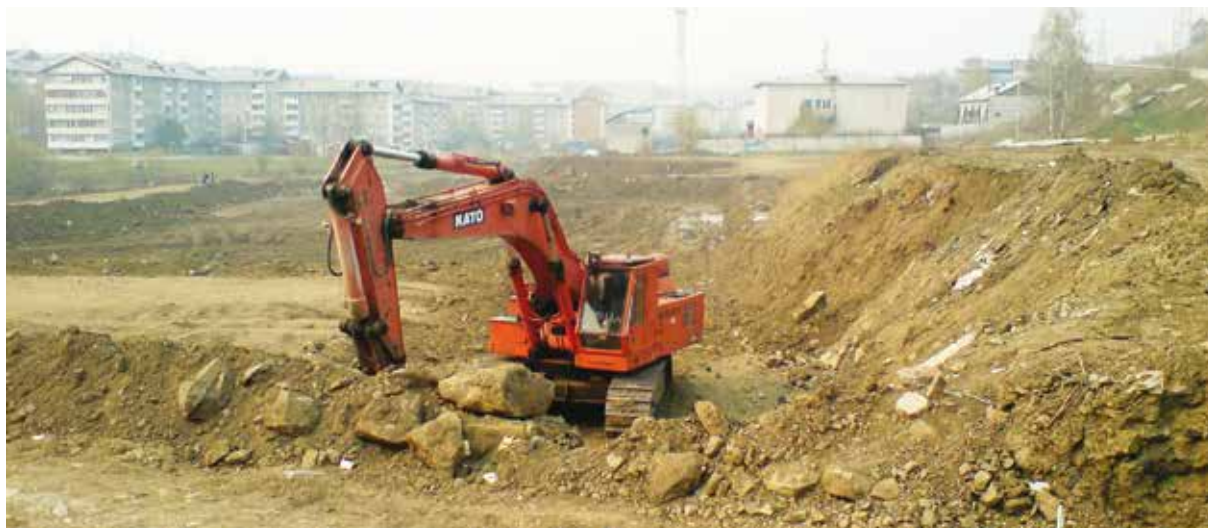
1. Строительство полуподземных гаражей с эксплуатируемой кровлей под автостоянку, застройщик ООО «Титул»
