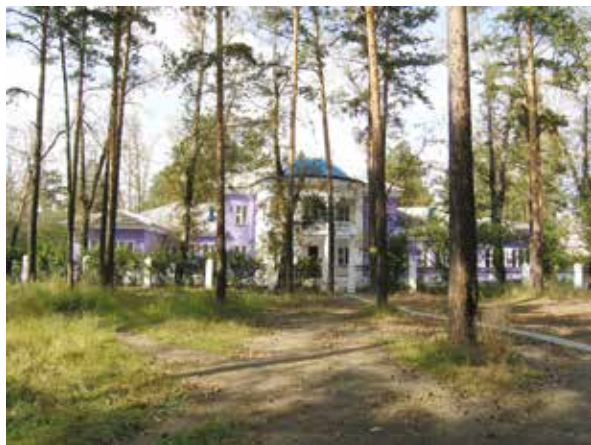
Здание детского сада Ангарск, улица Сибирская, 6. 1953. Архитектор В. Ярошук.
