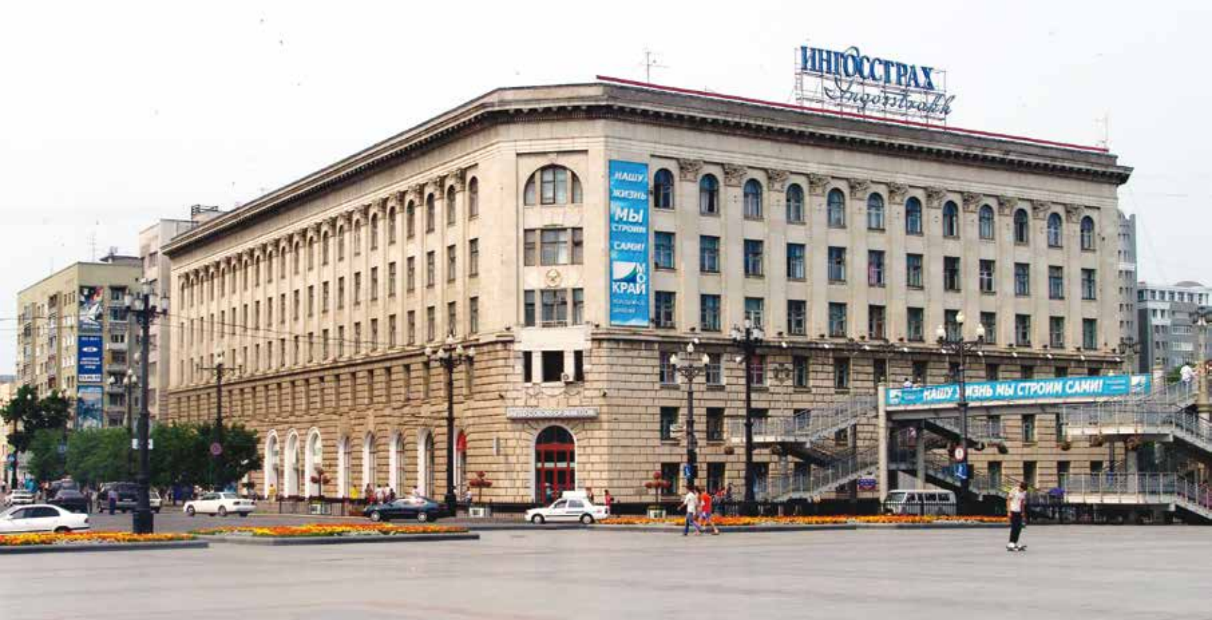
Здание ВПШ в Хабаровске. 1953 г. Арх. Петров М.Е. Общий вид, фрагмент с капителями
