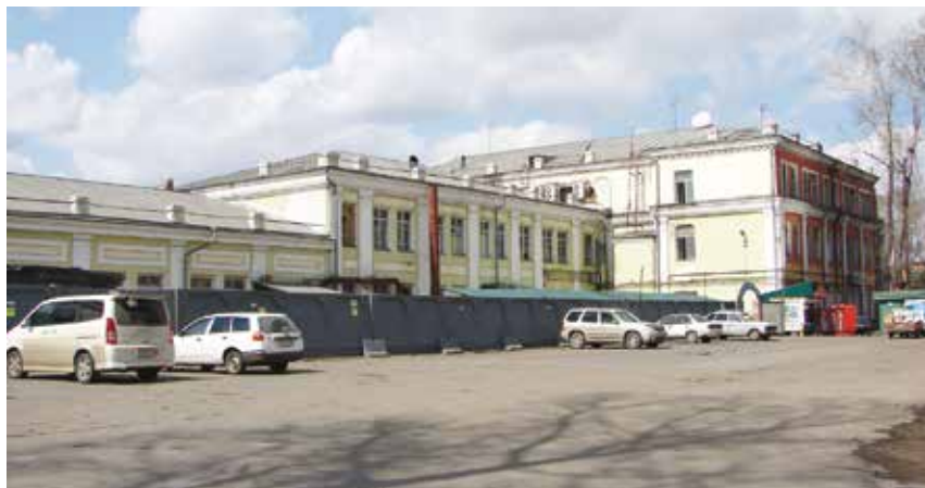
Здание фабрики-кухни по ул. Новаторов. Общий вид. Главный фасад
