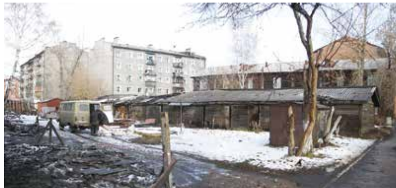
Рис. 12. Квартал двухэтажных деревянных жилых домов строчной застройки, пер. Восточный (пос. Ново-Ленино), 1937-1938-е
