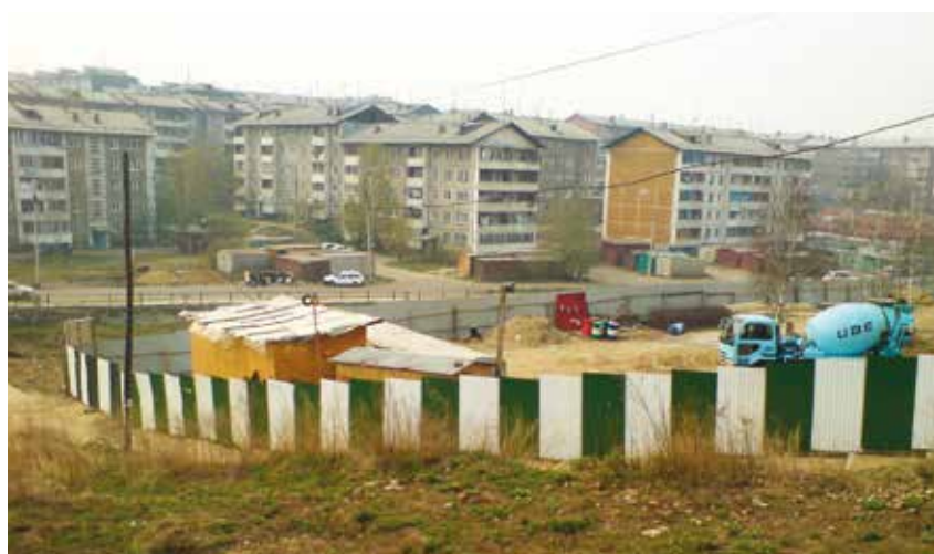
3. Строительство многоуровневой крытой автостоянки с автобоксами и еврогаражами, застройщик ООО «Росстрой-Инвест»
