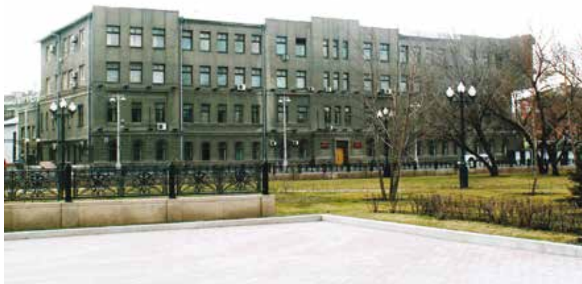
Реконструкция здания Городской Думы.
