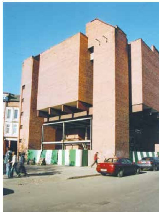
Пристрой к зданию ИГТРК в момент монтажа металлоконструкций, октябрь 2007
