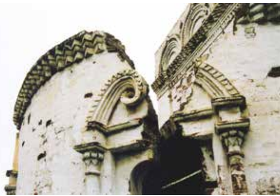
Фрагмент восточного фасада. Маяки
