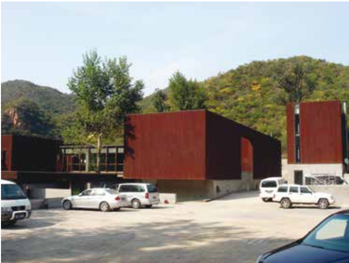
Поселок-коммуна вблизи Великой Китайской стены. Клуб включает в себя два ресторана (китайский и европейский), галерею, магазин, менеджмент-центр, бассейн и блок персонала. Ржавая сталь удивительно попадает по колеру и настроению в природное окружение
