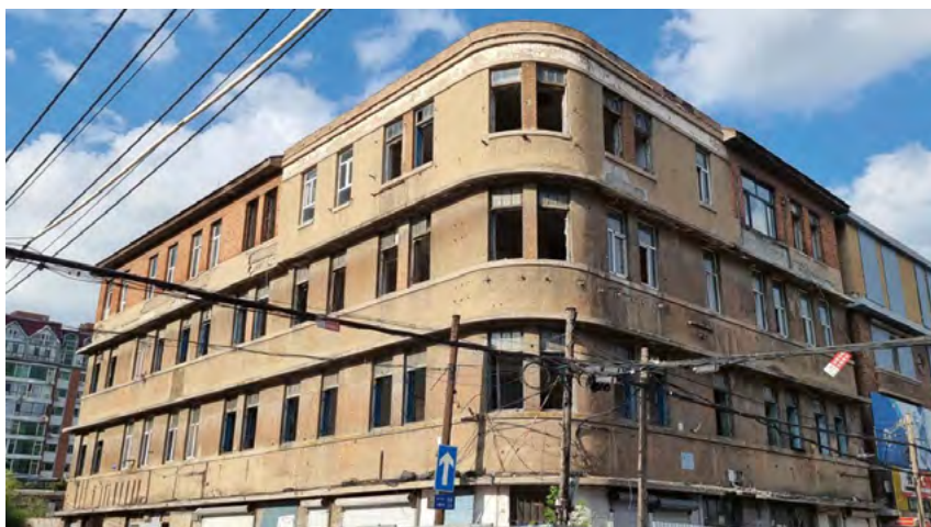
> Рис. 4. Конструкции. Фото авторов. 2023
