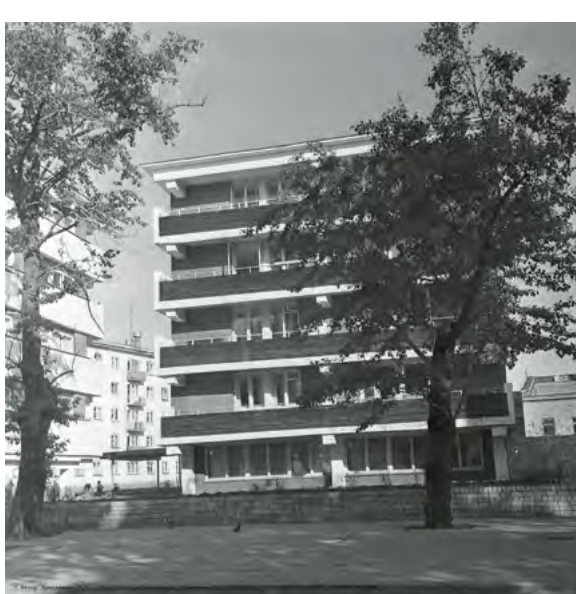
< Рис. 12. Дом по ул. Киевской, 9. Фото И. Дружининой
