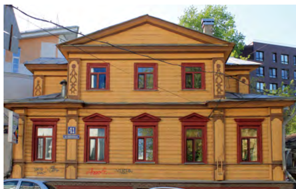
< Рис. 5. Нижний Новгород. Дом Е. Добролюбовой по улице Алексеевской, 41. Архитектор М. П. Камышников. 1837–1838
