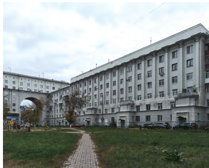
^ И. А. Голосов. Жилой комплекс Стройгаза, Нижний Новгород. 1935–1938. Фото Н. Васильева. 2015
