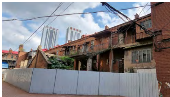
v Рис. 6. Галереи дворовых фасадов. Фото авторов. 2023
