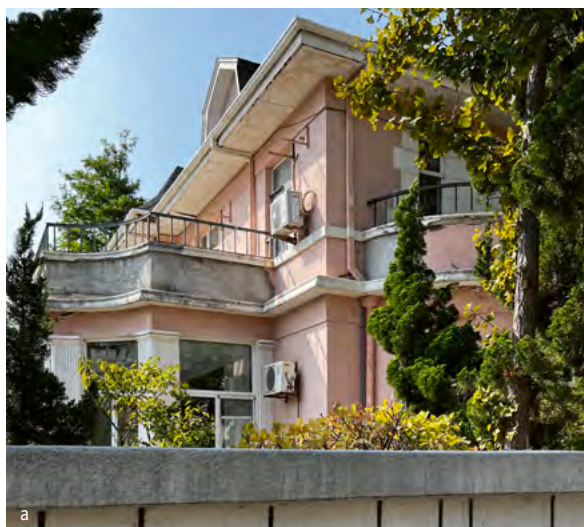
> Рис. 9. Текущее состояние застройки бывшего курортного поселка Кашегавры. Фото М. Е. Базилевича: а) отреставрированный объект б) объекты в разрушенном и ветхом состоянии
