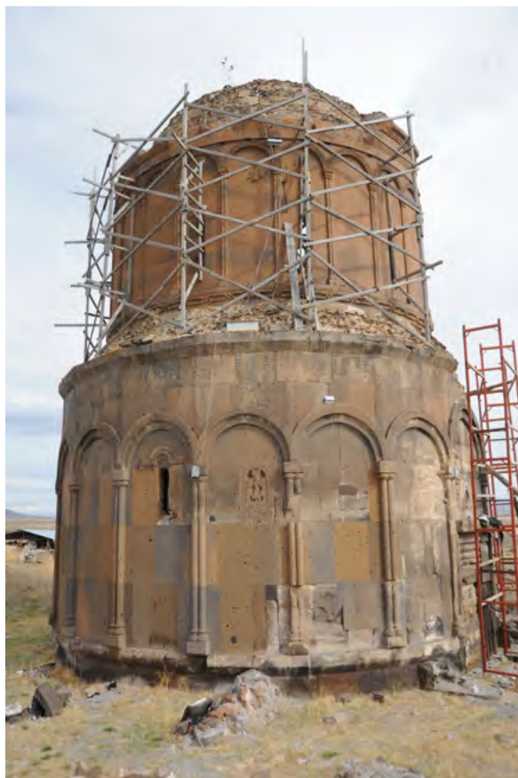
> Рис. 7. Церковь Спасителя в Ани. Вид с юго-запада после укрепления стен и остатка купола в 2014–2022 гг. Фото А. Казаряна. 2022
