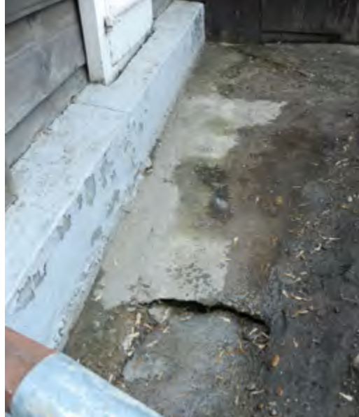
^ Рис. 8. Результат обследования цоколя и отмостки
