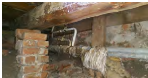
> Рис. 9. Биоповреждения подвального помещения
