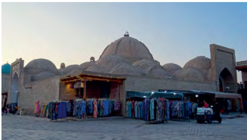
^ Рис. 12. Фрагмент купольной застройки рынка Заргарон
