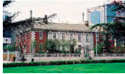
^ Рис. 18. Консульство Великобритании в Даляне. Постройка 1914
