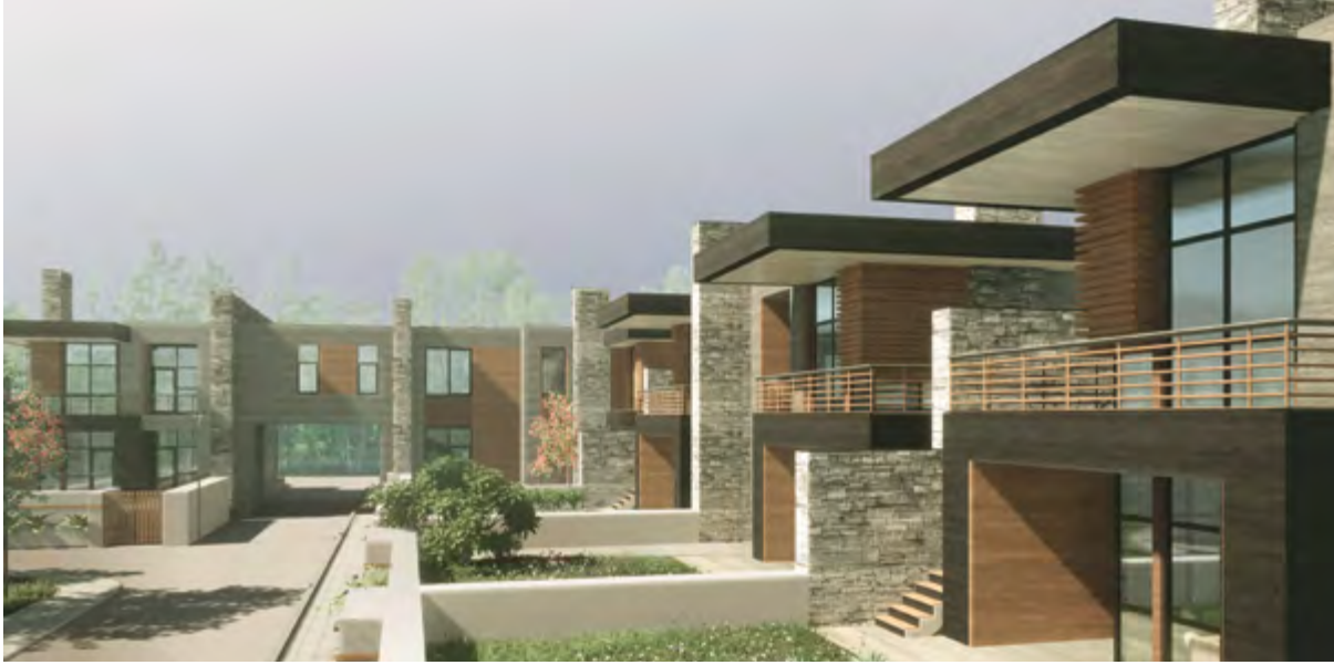
< v Блокированный дом с деревянными несущими конструкциями ООО ПТАМ «Студия 7». Авторский коллектив: Алексей Буйнов, Татьяна Котченко, Мария Серегина
