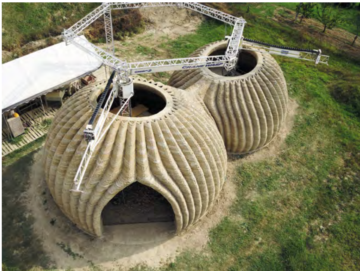
> Рис. 4. Глиняный дом в Ломбардии в процессе строительства / Figure 4. A clay house in Lombardy under construction
