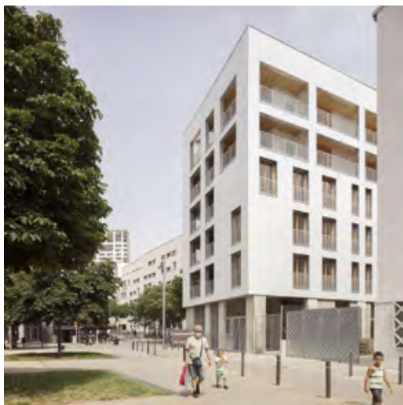
^ Рис. 16. Объект K20. Колинвинг «La Balma Collective Housing» ( https://clck.ru/33Xejji )
