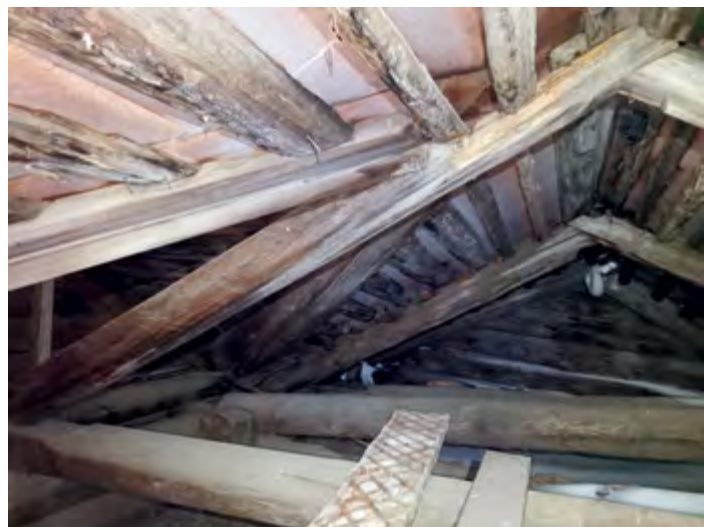
^ Подкровельные конструкции Петропавловской церкви
