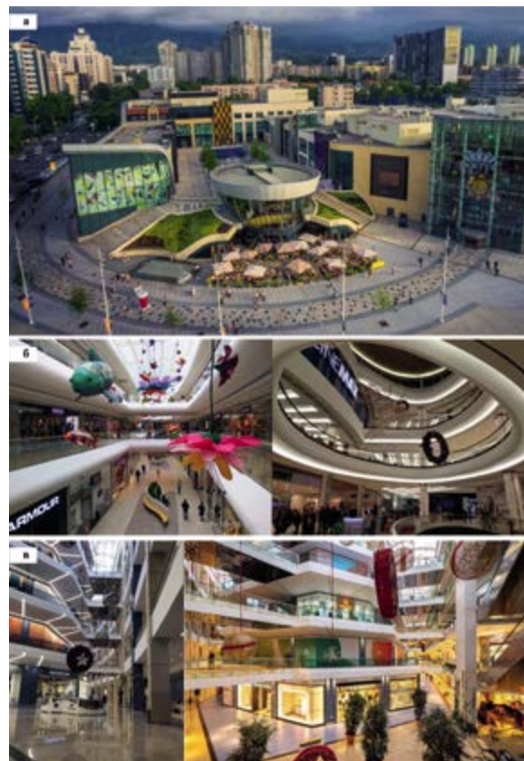
< Рис. 15. а – панорама на комплекс ТРЦ «Mega Centre Alma-Ata»; б – интерьерное пространство ТРЦ «Mega Centre Alma-Ata». – URL: https://cutt.us/q5KR9 ; в – интерьеры торгового центра «Алматы», расположенного в подземном пространстве под центральной площадью Алматы – Площадью Республики. – URL: https://old.almaly.kz/trade/
