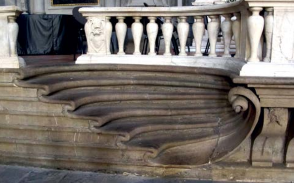
^ Рис. 10. Фьезоле, монастырь Сан-Доменико. Одна из лестниц. Архитектор Маттео Нигетти. 1574
