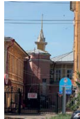
в Рис. 3. Здание почтово-телеграфной конторы в Чите, 1893. Архитектор М. Арнольд. Современное состояние. Вид со двора
