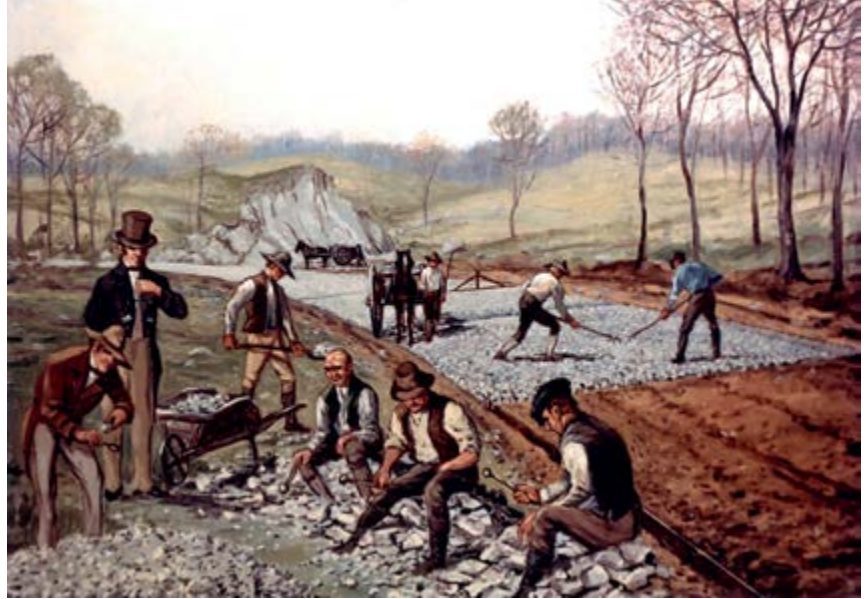
^ Рис. 10. Строительство трассы Кумберленд-роуд в штате Мэриленд (США) по методу Д. Макадама. 1830 г. – URL: http://www.1-day.ru/sob_09_21_1756.html
