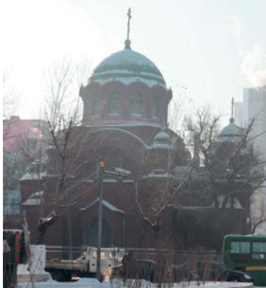
^ Рис. 2. Покровская церковь. Проект – 1905 г., постройка – 1930 г. Фото автора
