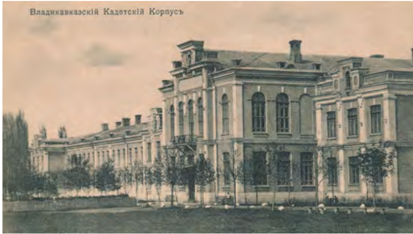
^ Здание главного здания Владикавказского кадетского корпуса, по образцу которого производилось планирование и постройка юнкерского и кадетского училищ в Иркутске. Почтовая открытка нач. XX века
