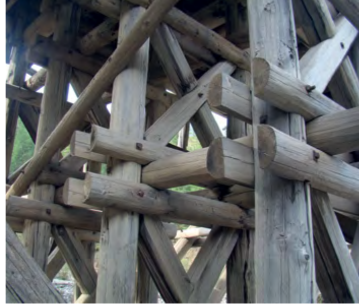
^ Рис. 23. Структура связей опоры моста
