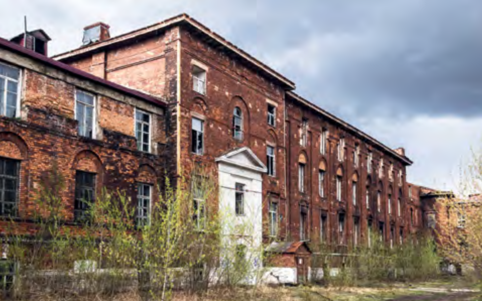
^ Общий вид основного объема с тыльной стороны, фрагмент дворового фасада
