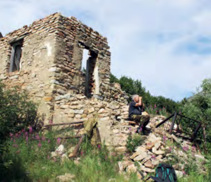
^ Рис. 6. Остатки здания
