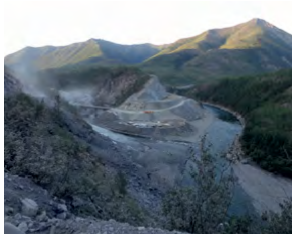
^ Рис. 19. Строительство новой дороги и мостов
