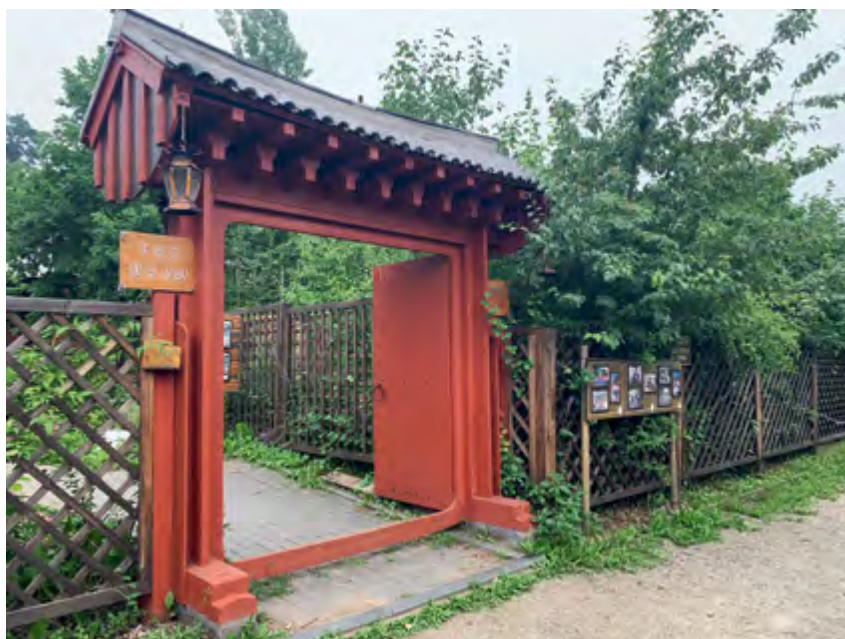
в Главные ворота и ограждение Корейского сада / The main entrance gate and fence of the Korean Garden
