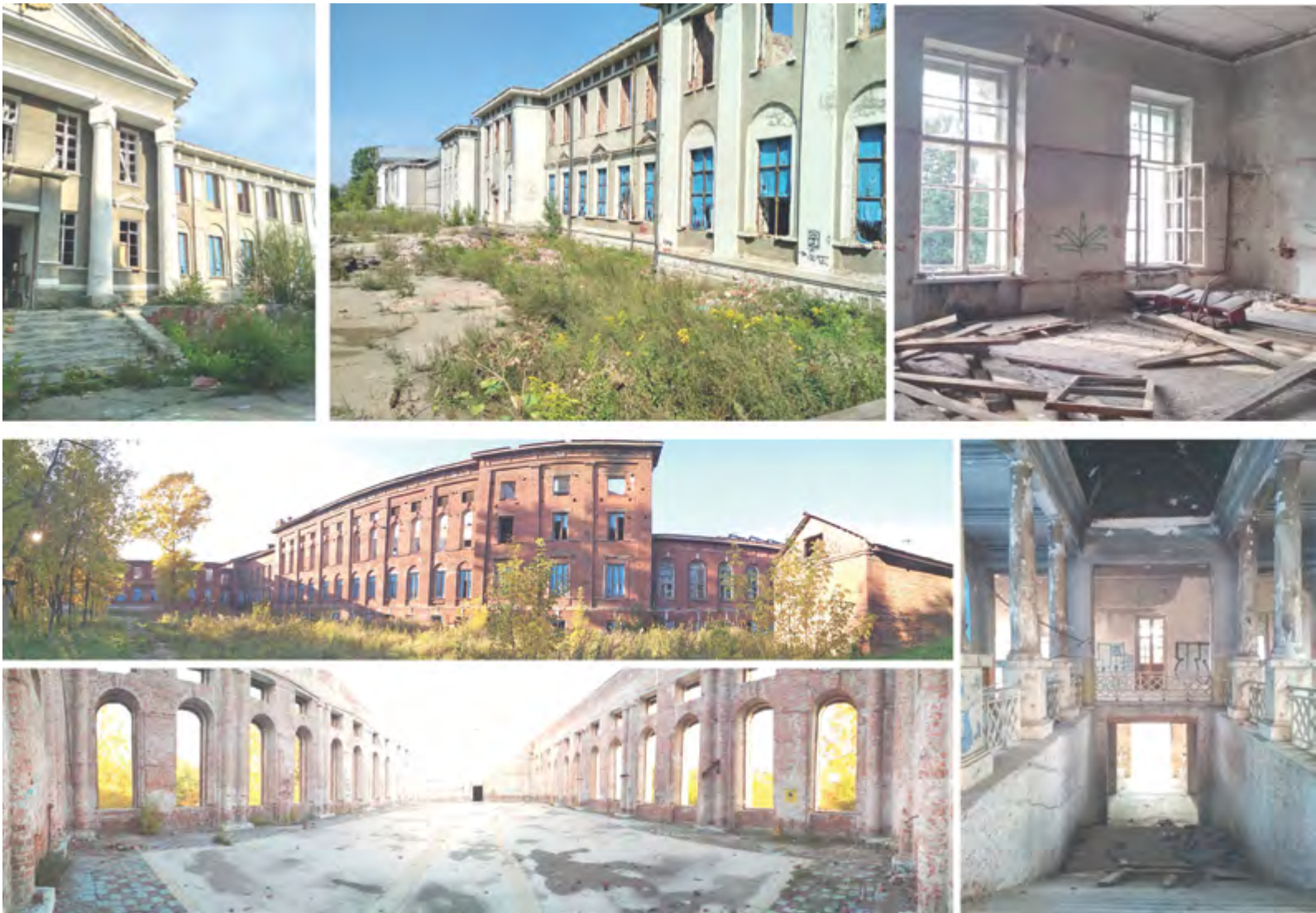
^ Рис. 6. Фотофиксация объекта: существующее состояние
