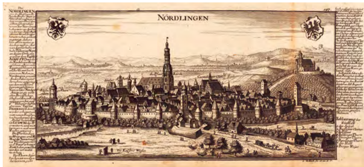
< Рис. 2. Противопоставление плотного тела города враждебной пустоте окружающего ландшафта отчетливо прочитывается в гравюрном изображении вида баварского Нордлингена. В отличие от многих городов европейского средневековья Нордлинген был построен не на возвышенности, а внутри естественного кольца – кратера, возникшего в этом месте метеорита 15 млн. лет назад
