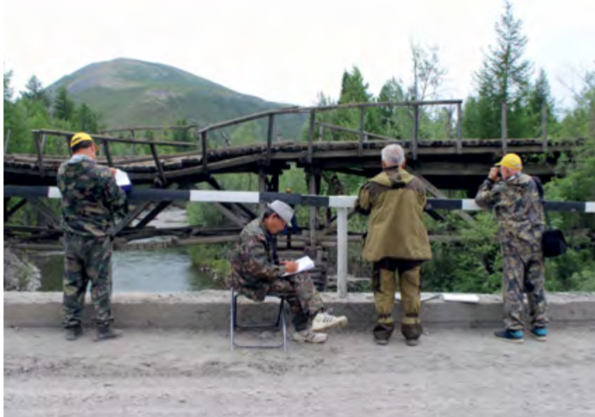
^ Рис. 26. Обмеры и фотофиксация моста членами экспедиции
