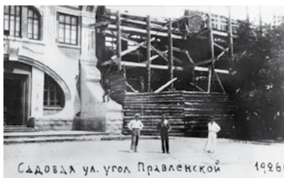
< Рис.4. Начало работ по пристройке ХПИ. 1926
