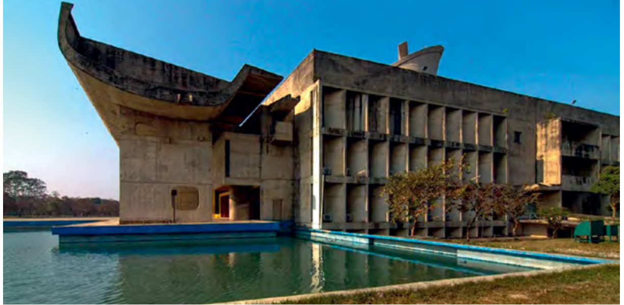
> Рис. 4. Неуместность не смущала модернистов: они брали места силой. Ле Корбюзье. Дворец Ассамблеи. Индия, Чандигарх. 1951–1962
