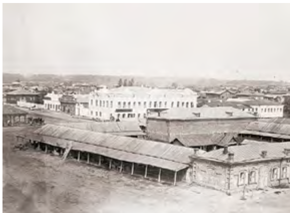
< Рис. 5. а – деревянный гостинный двор Ялуторовска. Фото конца 1890-х; б – каменные постройки гостинного двора, на заднем плане усадьба А. В. Колмакова. Фото начала XX в.
