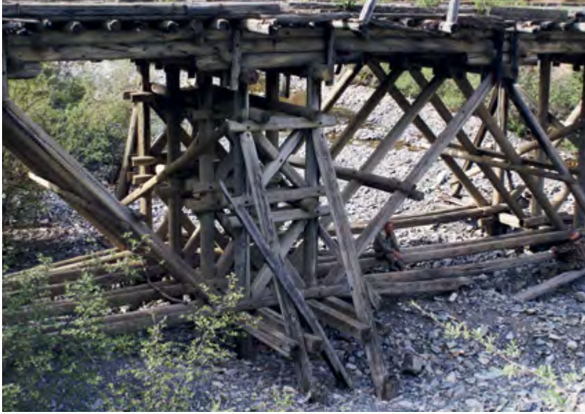
^ Рис. 22. Опорная конструкция одного из мостов
