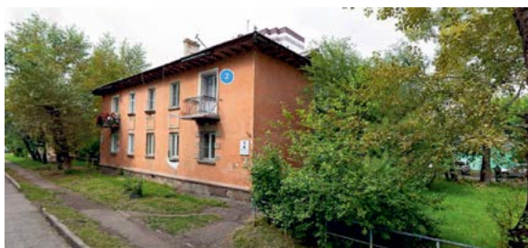
< Рис. 9. Каменный квартал. Кирпичные жилые дома в пер. Ярцевском, ул. Песочной и ул. Текстильщиков. Застройка 1940-х гг.
