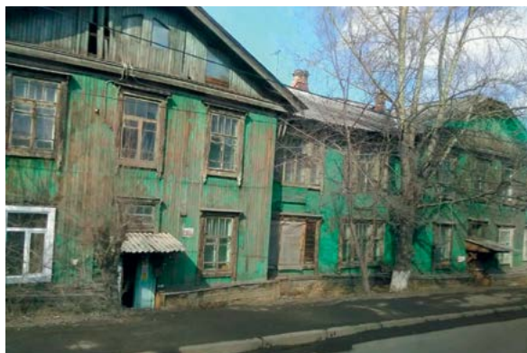
> Рис. 4. Деревянные многоквартирные дома по ул. Свердловской
