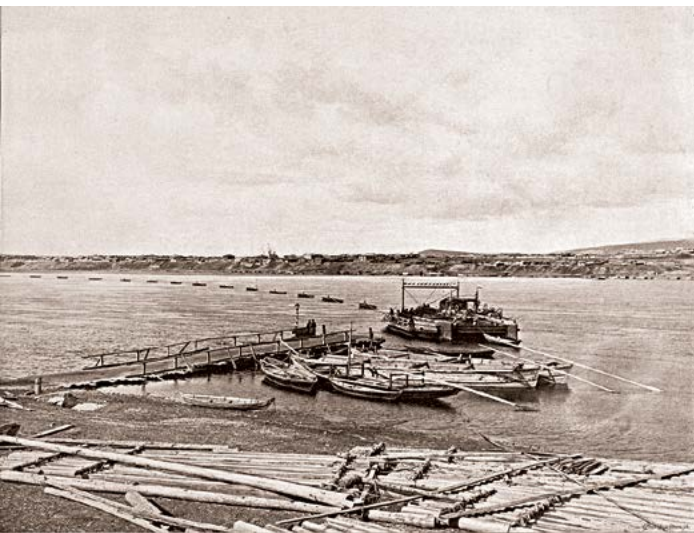
^ Рис. 2. Плашкоут – средство переправы через Енисей. Начало XX в. Фото из фондов Красноярского краевого краеведческого музея
