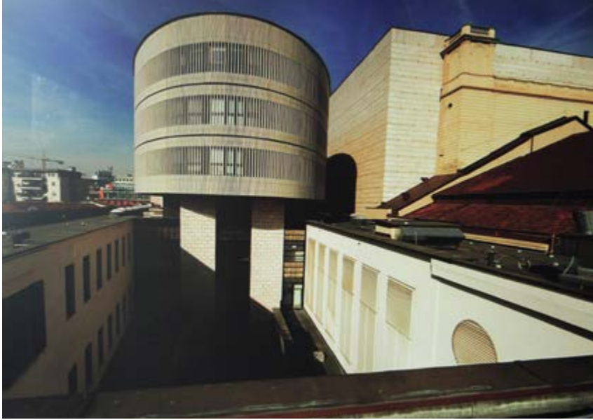
^ Трехэтажная надстройка над новым карманом сцены
