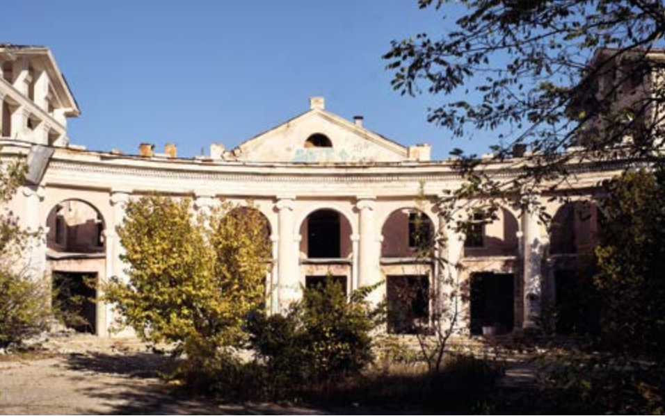
^ Евпатория. Санаторий «Октябрь». Архитектор В. Турчанинов. 1940, 1955
