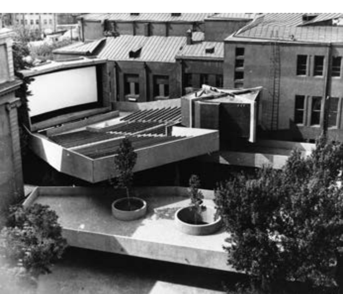
^ Рис. 3. Летний зал кинотеатра «Москва». Ереван. 1966. Арх. С. Кнтехцян, Т. Геворгян. Фото из архива К. Бальяна
