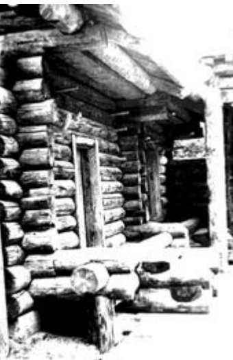
^ Фрагмент амбара (конструктивный узел)
