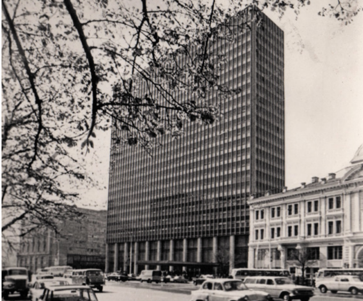
^ Рис. 2а. Застройка ул. Тверской. Гостиница «Интурист». Построена в 1970 году. Архитекторы В. Л. Воскресенский, Ю. Н. Швердьяев, А. С. Болтинов
