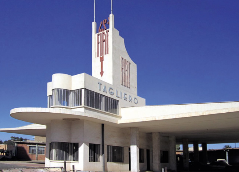
^ Станция обслуживания «Фиат Тальеро» в виде аэроплана. Архитектор Д. Петацци. 1938. Асмэра, Эритрея
