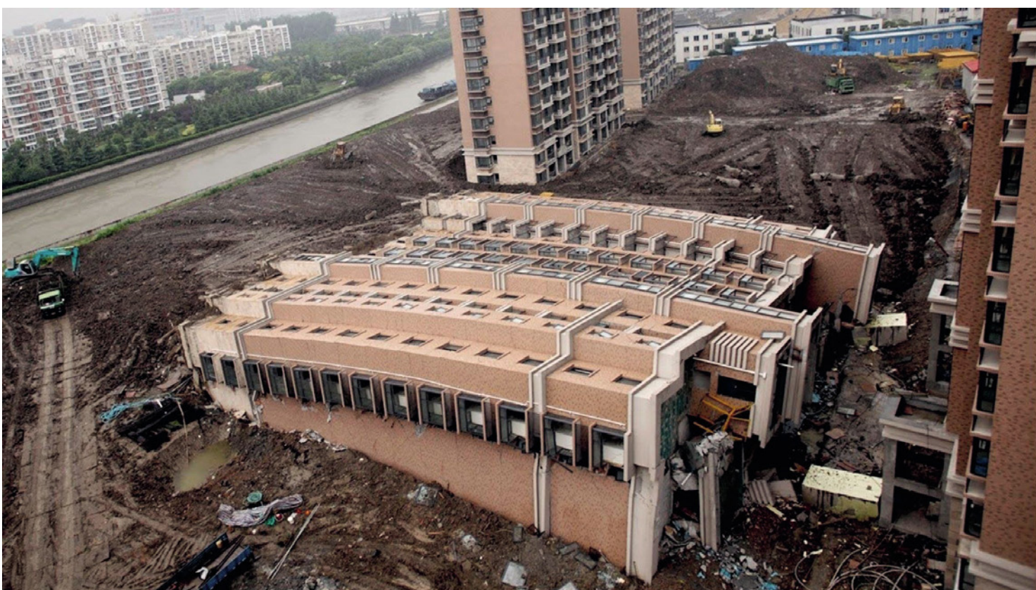
^ Рис. 16. «Неустойчивые» здания. Шанхай, землетрясение 2009 г.
