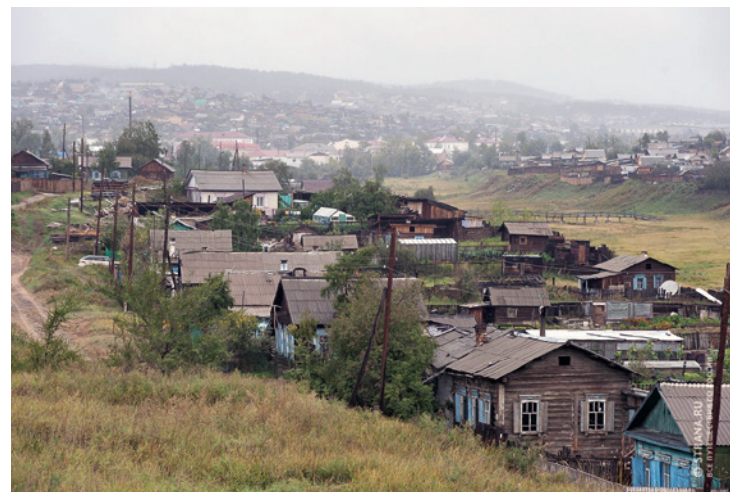
^ Деревянная застройка Кяхты
