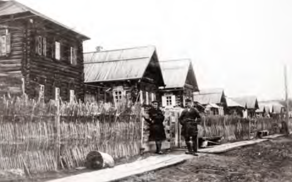
^ Застройка улицы в с. Спасском
