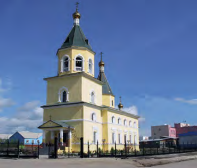
^ Спасский собор: вид с юго-западной стороны
