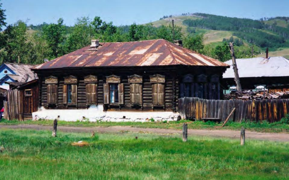
^ Рис.16. Деревянный одноэтажный дом типа «пятистенок»
