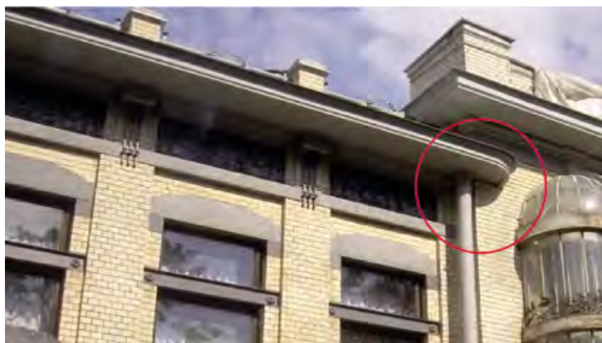
^ Рис. 13. Карниз с водосливом на главном фасаде особняка Кшесинской
