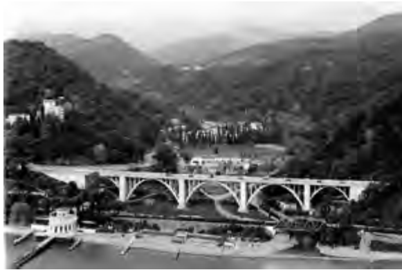
v Мацестинский мост. Арх. Щуко В.А., Гельфрейх В.Г., 1938 г.
