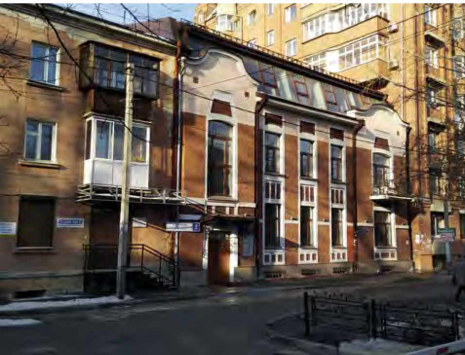
v Рис. 5. Главный фасад. Фото 2014 г.
