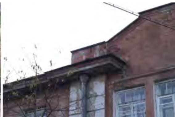
< Рис. 14. Здание приюта купца Родионова, ул. Дзержинского, 43. Архитектор В. Коляновский. Общий вид и фрагмент
