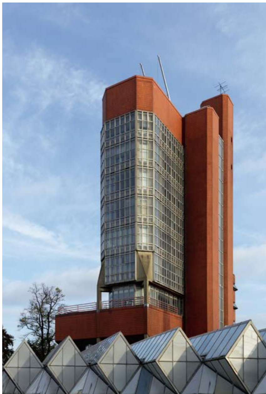
в Две постройки по проектам Джеймса Стерлинга: Инженерный факультет Университета в Лестере, Англия, 1959 / The two buildings designed by James Sterling: Leicester University Engineering Department, Great Britain, 1959
