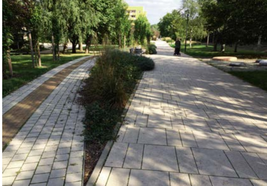
^ Рис. 10; 11. Главная ось района Горбиц (Дрезден) вдоль маршрута легкорельсового транспорта, в отдалении от автомобильного движения. Схема и фото Л. Козловой
