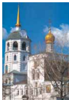
Спасская церковь г. Иркутск Вид с юго-востока Фото И.Ю. Бержинского
