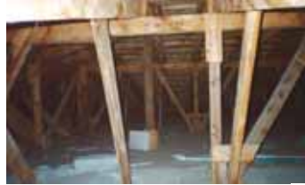
Теплоизоляция чердачного перекрытия «Поропластом CF 02» Фрагмент теплоизоляции
