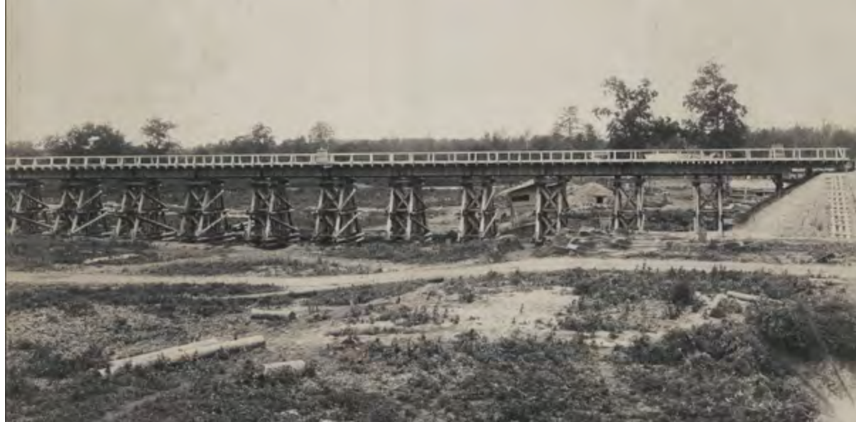
< Рис. 2. Деревянный мост через р. Кию близ станции Переяславка [9]
