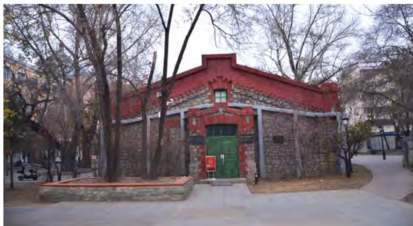
^ Рис. 6. Здание бывшей воинской казармы. Южный фасад
