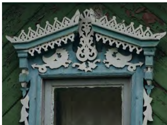
^ Рис. 5. Фрагмент традиционного оконного наличника. Нерехта, Костромская область
