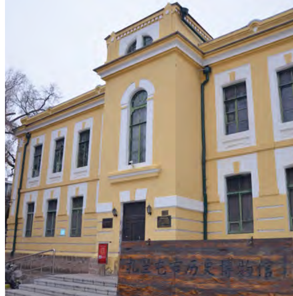
^ Рис. 3. Здание бывшего железнодорожного клуба в Чжалантуне. Главный фасад
