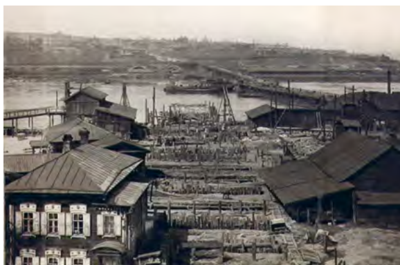
< Рис. 17. Расчистка жилого квартала под строительство моста [11]
