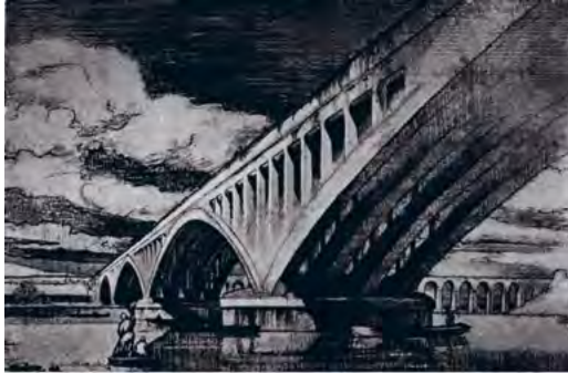
196. Железобетонный мост на р. Твид в Беринге, Англия. Инженеры Вудгау и Лорн, 1928 г. Пролеты: 51 + 75,6 + 87 + 110 м, стрелка 1:7,9, ширина 17 м
