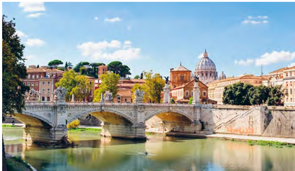
^ Рис. 6. Железобетонный мост на р. Тибр (Италия) [7]
