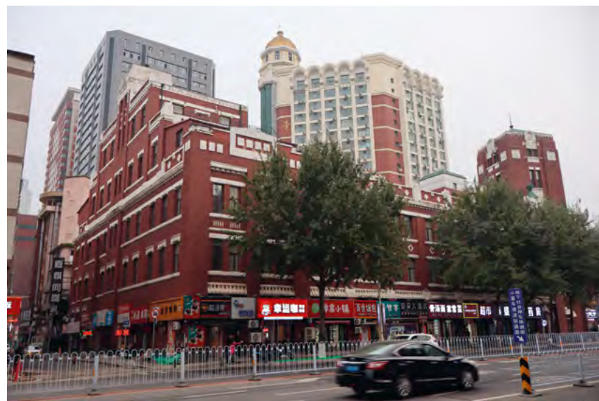
v Рис. 2. Привокзальная площадь. Вид на периметральную застройку. Фото Д. Целуйко, 2025
