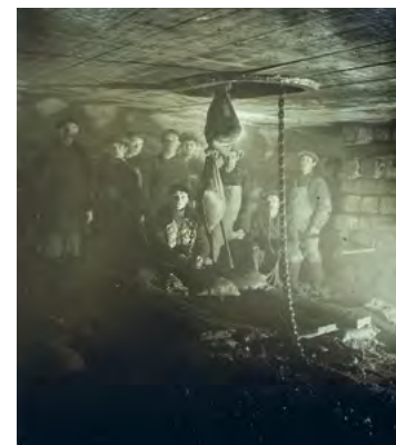
^ Рис. 15. Выемка грунта в кессоне [12]
