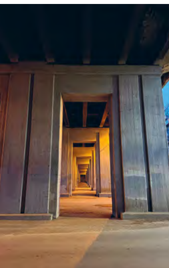
^ Рис. 4. Опоры Глазковского моста (правый берег), 2026. Фото В. Лисицина
