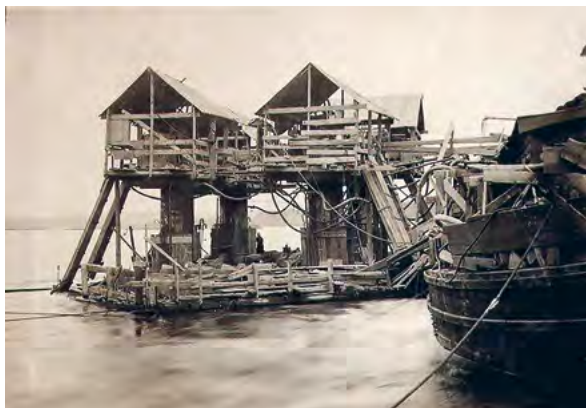
^ Рис. 14. Опускание кессона № 2, 1934 [11]
