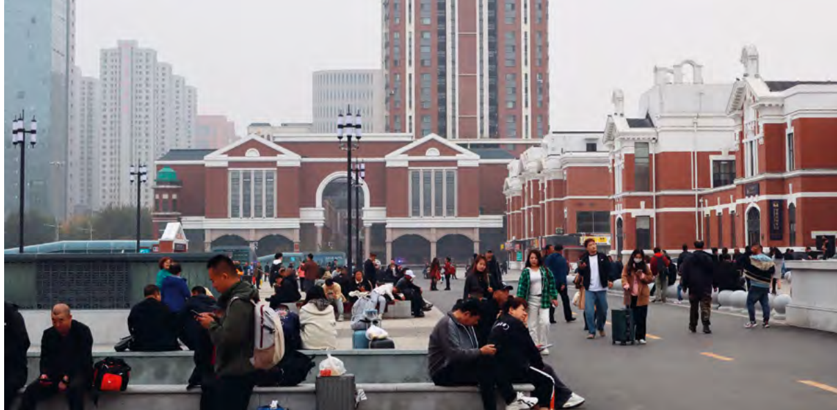
> Рис. 1. Привокзальная площадь. Вид на боковое крыло вокзала. Фото Д. Целуйко, 2025
