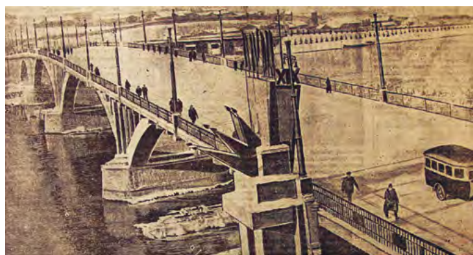
^ Рис. 23. Глазковский мост. Общий вид с правого берега [13]
