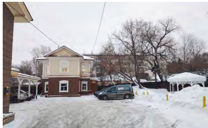
^ Рис. 6. Вид усадьбы по ул. Красноармейской, 78, после ревитализации. Фото Е. Ситниковой. Декабрь 2025 года
