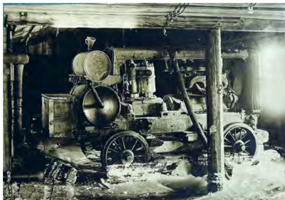
> Рис. 12. Бетономешалка системы Кайзера [10]
