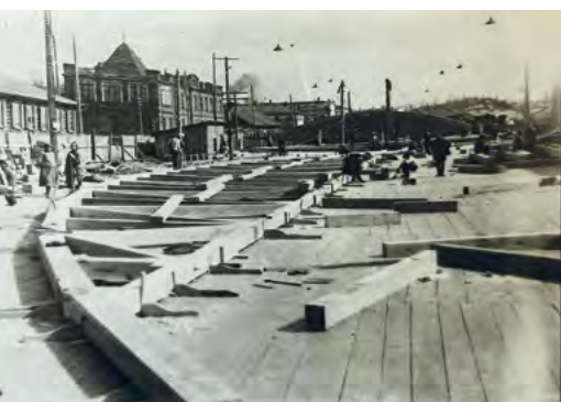
^ Рис. 18. Сборка кружал на берегу [12]
