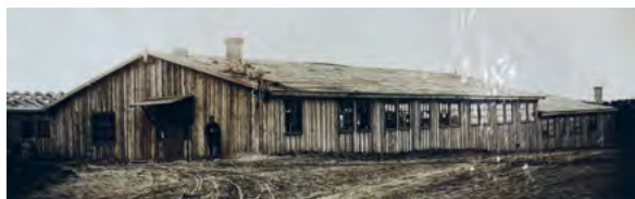
> Рис. 13. Барак для рабочих-мостостроителей [10]
