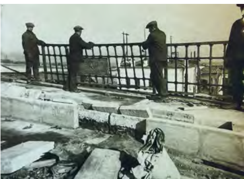
^ Рис. 22. Установка ограждения моста, 1936 [12]
