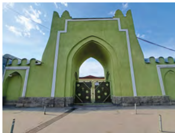
^ Рис. 1. Входная группа в здание винного завода «Бахус»
