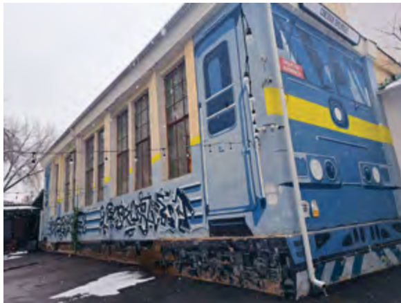
< Рис. 6. Фасад с восточной стороны здания арт-пространства, называемого «Дом на Барибаева»
