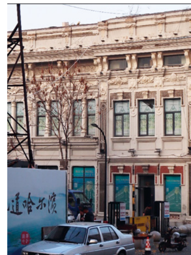
^ Рис. 7. «Медальоны» на фасаде здания, 2024. Фото Д. Целуйко
