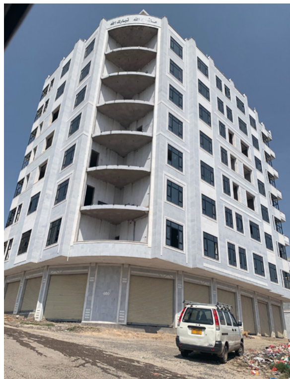
> Рис. 2. Широкое использование остекления без надлежащего затенения в современных жилых зданиях в Йемене приводит к увеличению поступления солнечного тепла и снижению энергоэффективности. Фото автора / Fig. 2. Extensive use of glazing without adequate shading in contemporary residential buildings in Yemen, leading to increased solar heat gain and reduced energy efficiency (source: author's photos, Ibb)
