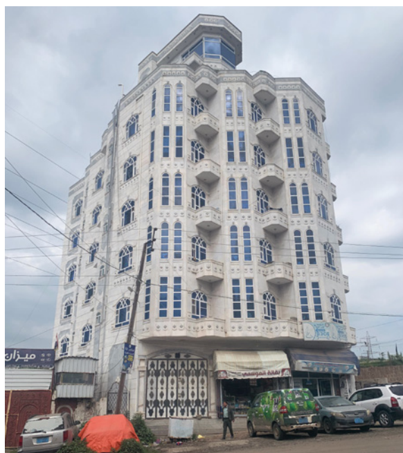
< Рис. 1. Использование остекления большой площади. Фото автора / Fig. 1. Use of large-area glazing (source: author's photos)
