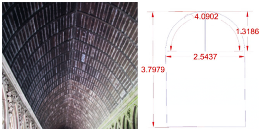
в Рис. 13. Деревянный потолок портика клуатра в аббатстве Мон-Сен-Мишель со схематическим изображением, показывающим размеры и пропорции. Фото Ипполит де Сен-Рамбер, Wikimedia Commons / Fig. 13. Wooden ceiling of the cloister portico at Mont-Saint-Michel Abbey with a schematic diagram indicating the dimensions and proportions. Source: Photography by Hyppolyte de Saint-Rambert, via Wikimedia Commons ( https://commons.wikimedia.org/wiki/File:Abbatiale_de_Mont_Saint-Michel_hdsr_IMG_3836.jpg )
