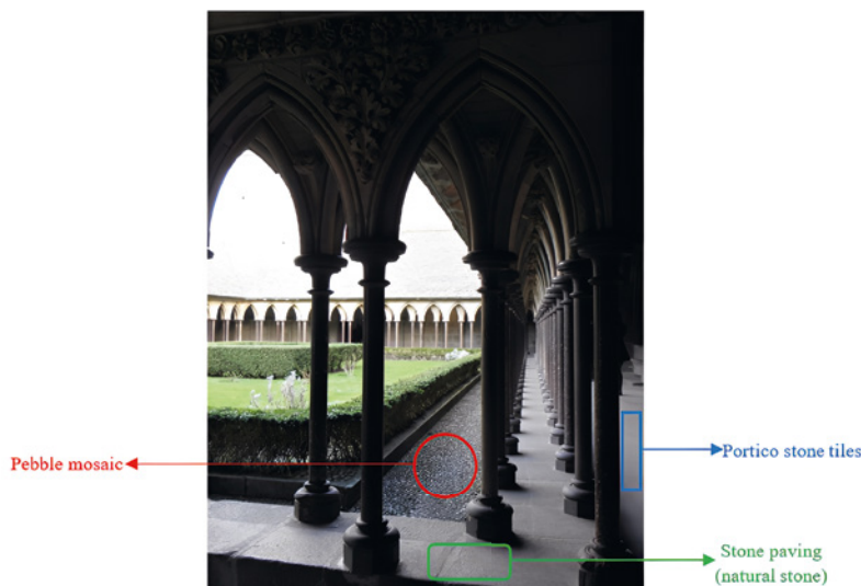
в Рис. 12. Композиция пола в клуатре аббатства Мон-Сен-Мишель, представляющая собой дорожку, выложенную мозаикой из гальки, и мощение портика натуральным камнем. Фото G069, Wikimedia Commons / Fig. 12. Floor composition of the cloister at Mont-Saint-Michel Abbey illustrating the pebble mosaic path and natural stone paving in the portico. Source: Photography by G069, via Wikimedia Commons ( https://commons.wikimedia.org/wiki/File:Mont-Saint-Michel_(50)_Abbaye_Clo%C3%Aetre_02.JPG )
