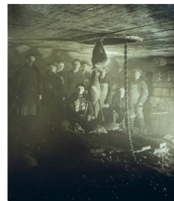
^ Рис. 15. Выемка грунта в кессоне [12]
