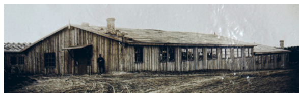
> Рис. 13. Барак для рабочих-мостостроителей [10]
