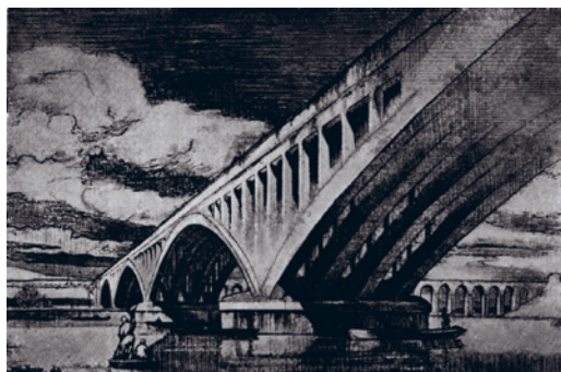
196. Железобетонный мост на р. Тэм в Бернлике, Англия. Инженеры Вудгауз и Лори, 1928 г. Пролеты: 51+75,6+87+110 м, стрелка 1:7,9, ширина 17 м
