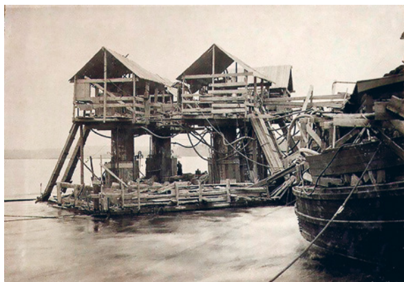
^ Рис. 14. Опускание кессона № 2, 1934 [11]
