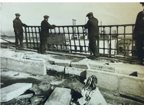
^ Рис. 22. Установка ограждения моста, 1936 [12]
