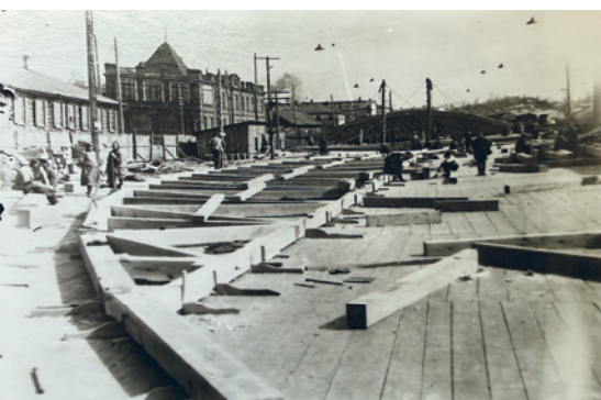
^ Рис. 18. Сборка кружал на берегу [12]
