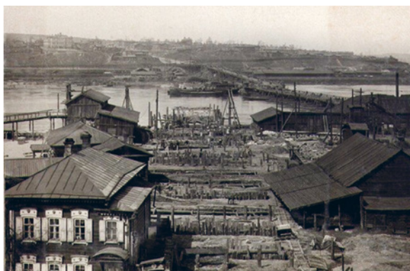
< Рис. 17. Расчистка жилого квартала под строительство моста [11]
