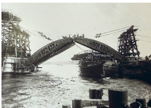
^ Рис. 19. Соединение кружал [12]
