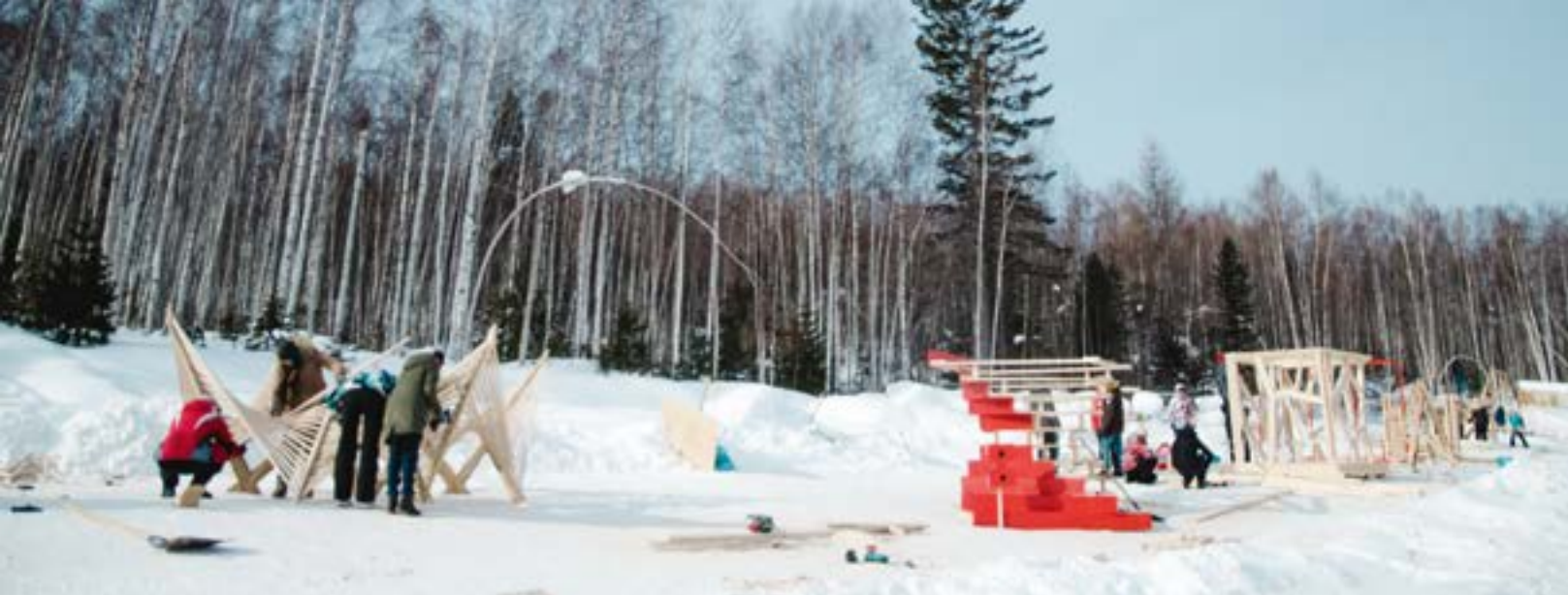
^ Панорама строительной площадки фестиваля
