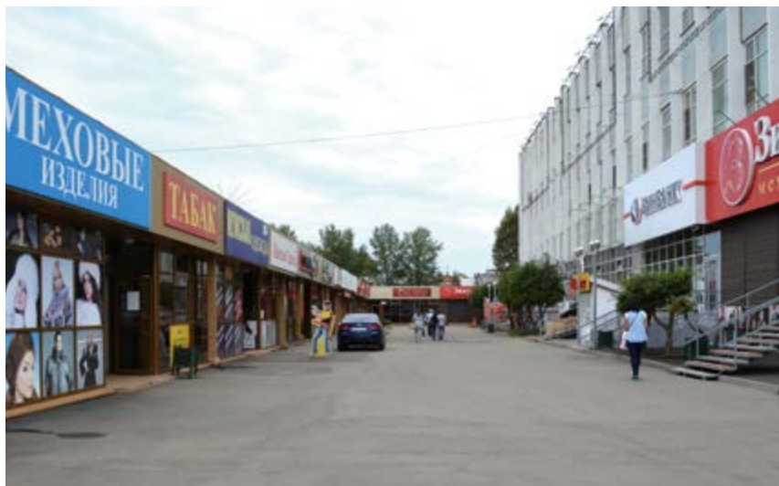
v Торговый комплекс. Современное состояние
