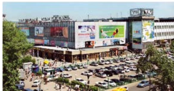
v Торговый комплекс. Современное состояние
