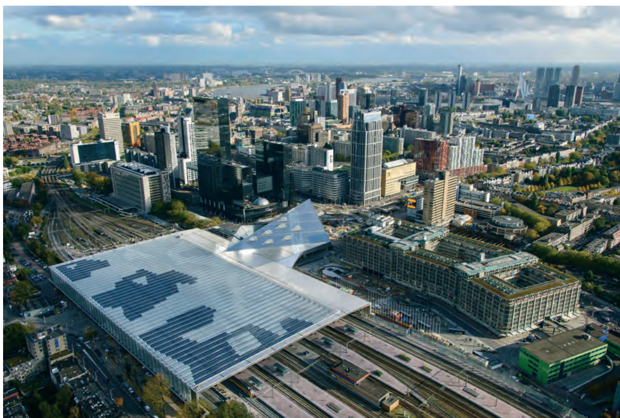
< Крыша с солнечными батареями / The solar roof
