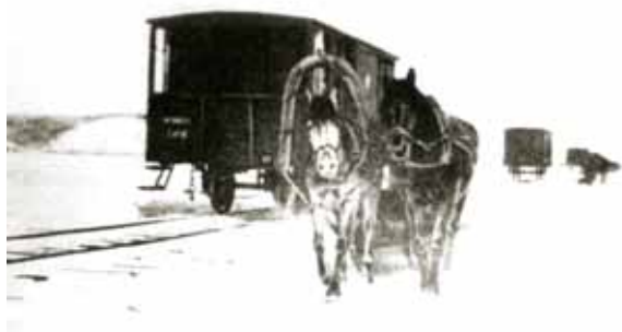
^ Перевозка вагонов лошадьми по ледовой железной дороге
